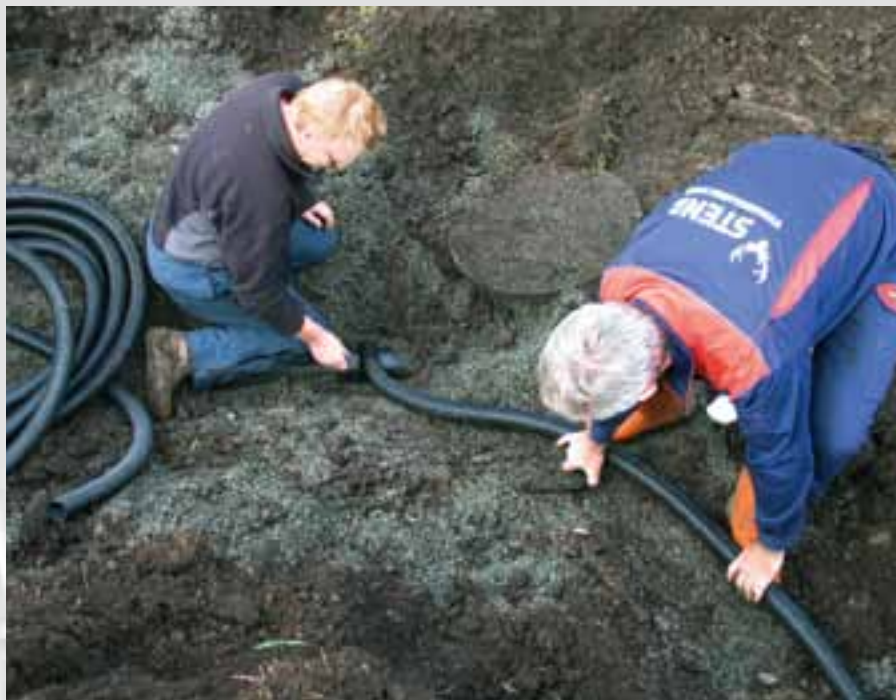
Ennå uferdig sammenkopling av sugerør og samlerør. Det er praktisk å bruke koblingsdel som er tilpasset, og det må brukes godt med filtermateriale på koblingspunktet. Foto: Bente Opstad.
